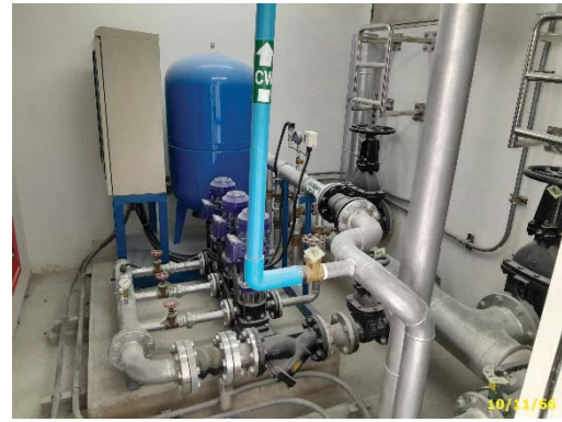
Booster Pump อาคาร X
